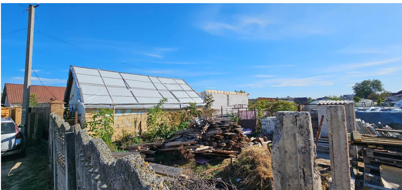
С. Велика Димерка. Будівельний майданчик на місці зруйнованої житлової забудови (фото автора 11.10.2023).
