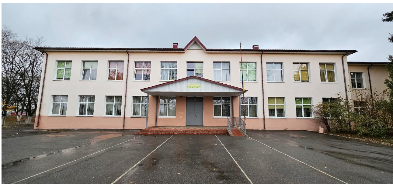
С. Димер. Димерський ліцей №1. Після окупації здійснено вдовлювальні ремонтні роботи за підтримки Громадської організації Жіночий Консорціум України. Зокрема: покладено ламінат, улаштовано підвісну стелю, демонтовано старе покриття, проведено штукатурні роботи та пофарбовано стіни. Також забезпечили гуманітарною допомогою: планшети, телевізори,
